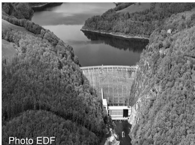
De type « poids », le barrage de Sarrans est implanté à 70 km de la ville de Rodez sur les communes de Brommat et de Sainte-Geneviève-sur-Argence en Aveyron et sur le Cantal. La retenue d'eau est la 8<sup>ème</sup> plus importante de France. Avec 183 MW de puissance installée, le site hydroélectrique de Sarrans produit chaque année l'équivalent de la consommation résidentielle annuelle de 112 000 habitants. (Source EDF)
